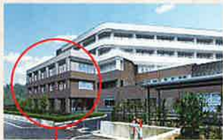
増築予定部分(平成25年11月完成予定)
