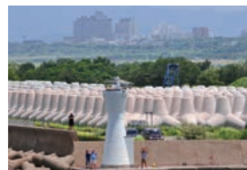
金沢港大浜頭沖から見た金沢医科大学病院
