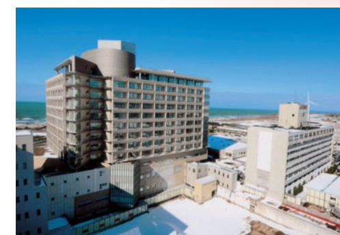
金沢医科大学臨床研究棟屋上より見た金沢医科大学病院
