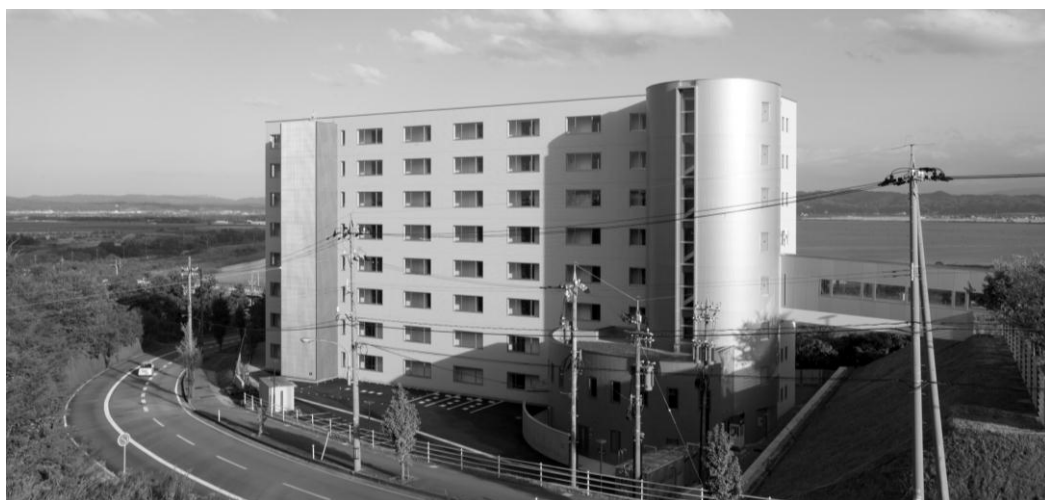
レジデントハウス（竣工時撮影）
