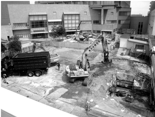
旧アナトミーセンター解体終了時
