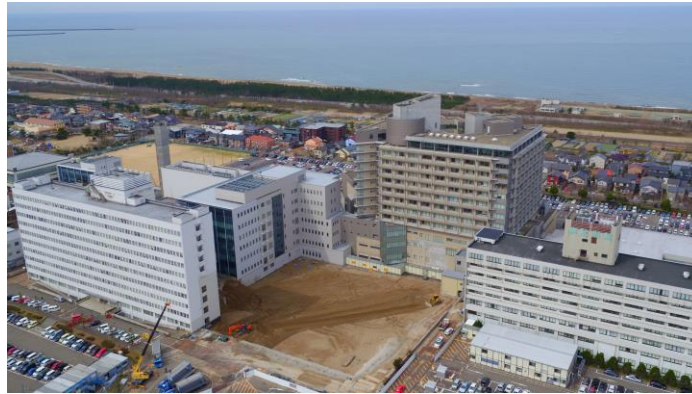
病院本館解体
