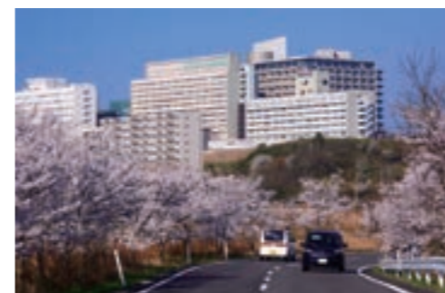
県道高松・内灘線から見た金沢医科大学病院
